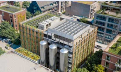
Drei Großwärmespeicher, eine Luft-Wasser-Wärmepumpe und ein Power-To-Heat-Modul sorgen dafür, dass die „Klimagarage“ bis zu 430 Haushalte mit Wärme versorgen kann.
