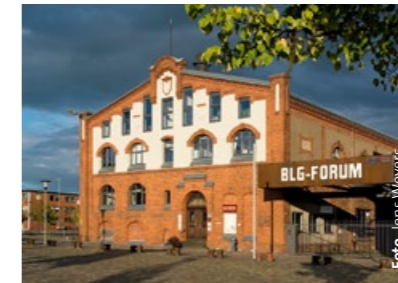
Das Event „Bremen Fast Forward“ soll in der Energieleitzentrale stattfinden.
