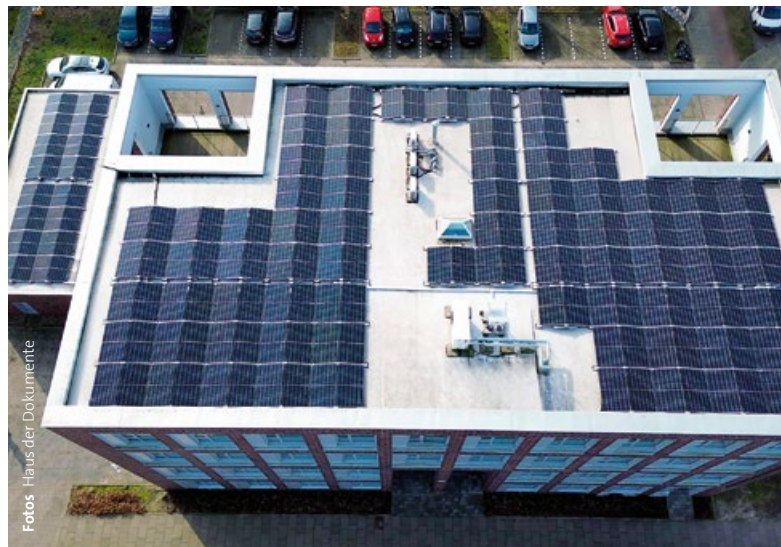
Die Photovoltaikanlage zahlt sich ökologisch und wirtschaftlich aus.
