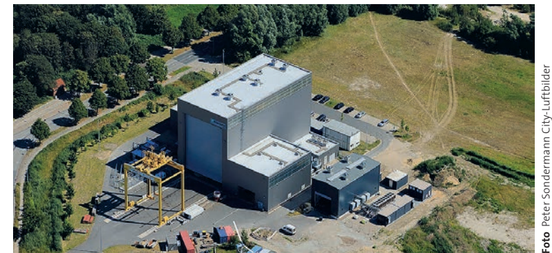
Die IWES-Großprüfstände in Bremerhaven; das dunkle, kleinere Gebäude vor der großen Halle ist das neue Labor.
