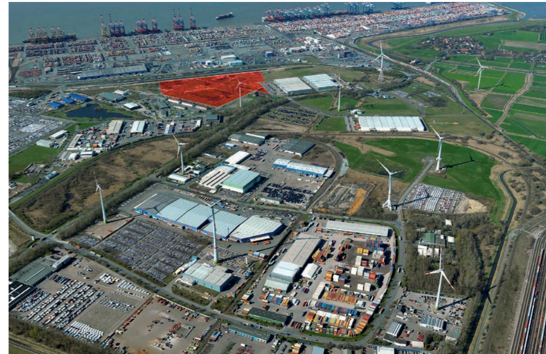
Rot markiert ist die Fläche von 13,7 Hektar auf dem LogInPort Bremerhaven, die Mafi & Trepel erworben hat.
